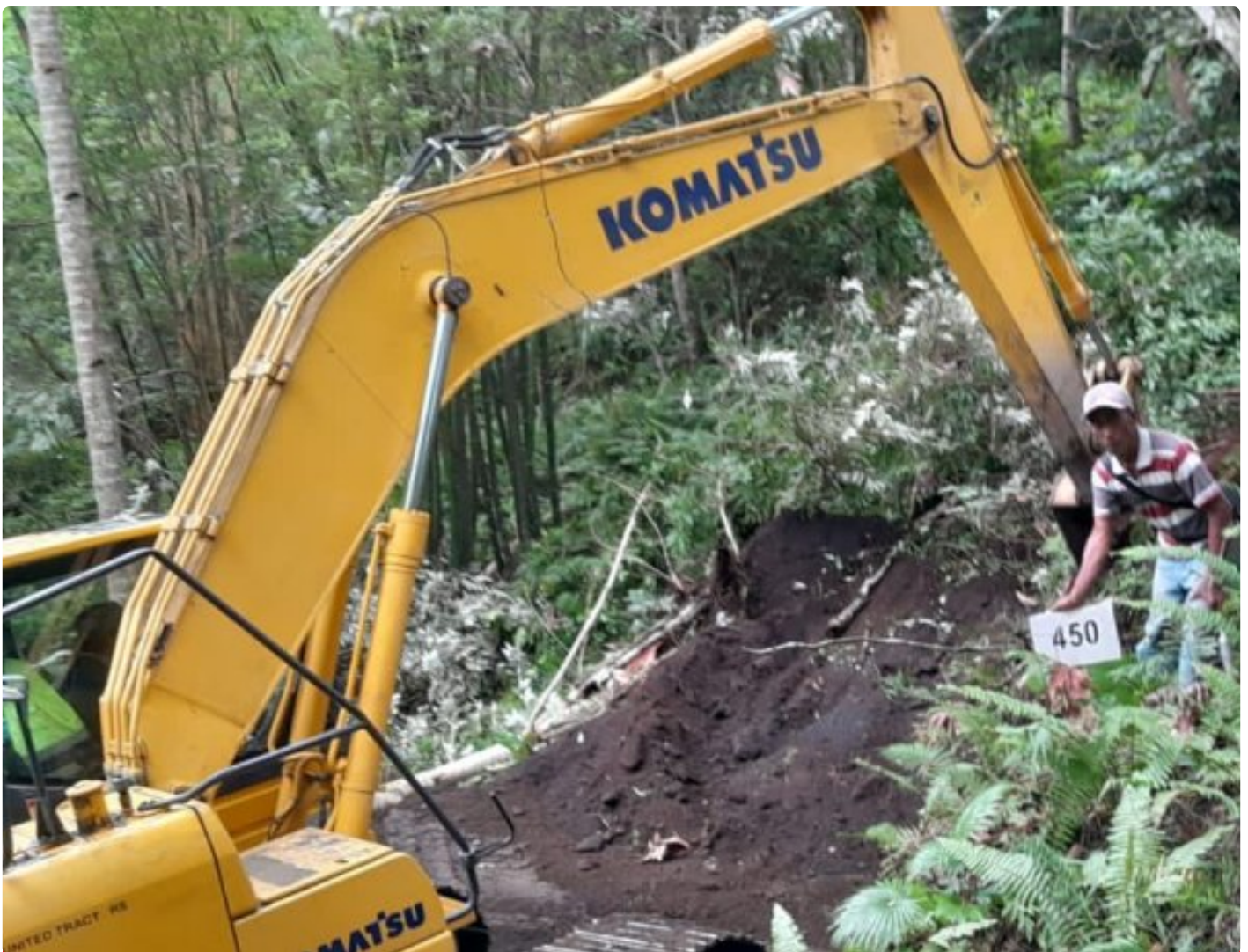
TMMMD Ke-116, Kebut Kerja pembuksan akses Jalan
