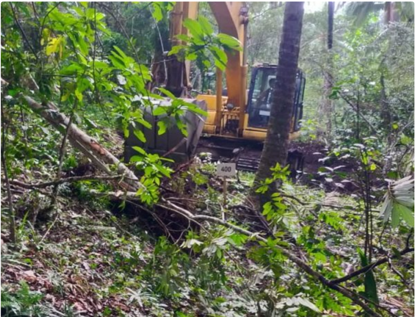
Pekerjaan akses Jalan TMMD Ke-116
