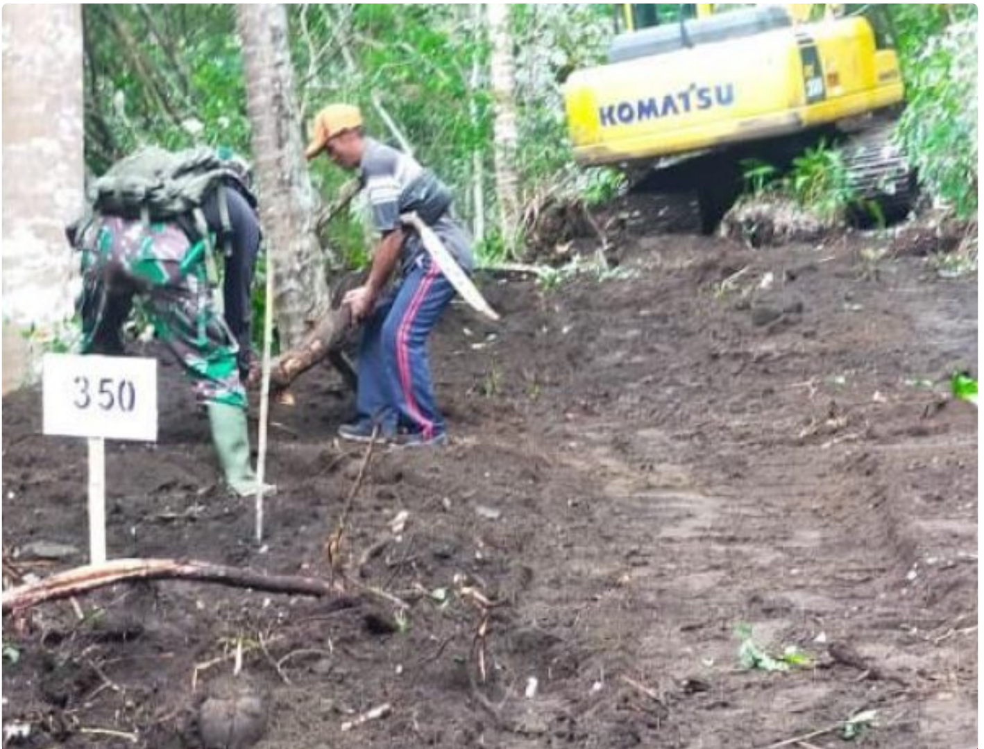
Pembukaan Akses Jalan oleh Satgas TMMD Ke-116 di Kelurahan Tandurusa. Capai 350 Meter
